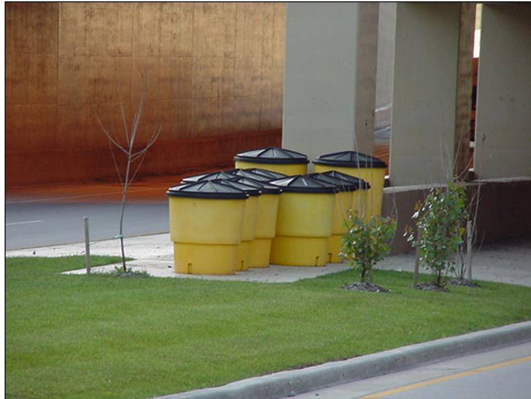
**Figure 2.9.3.3-1:** Impact Attenuator System.
