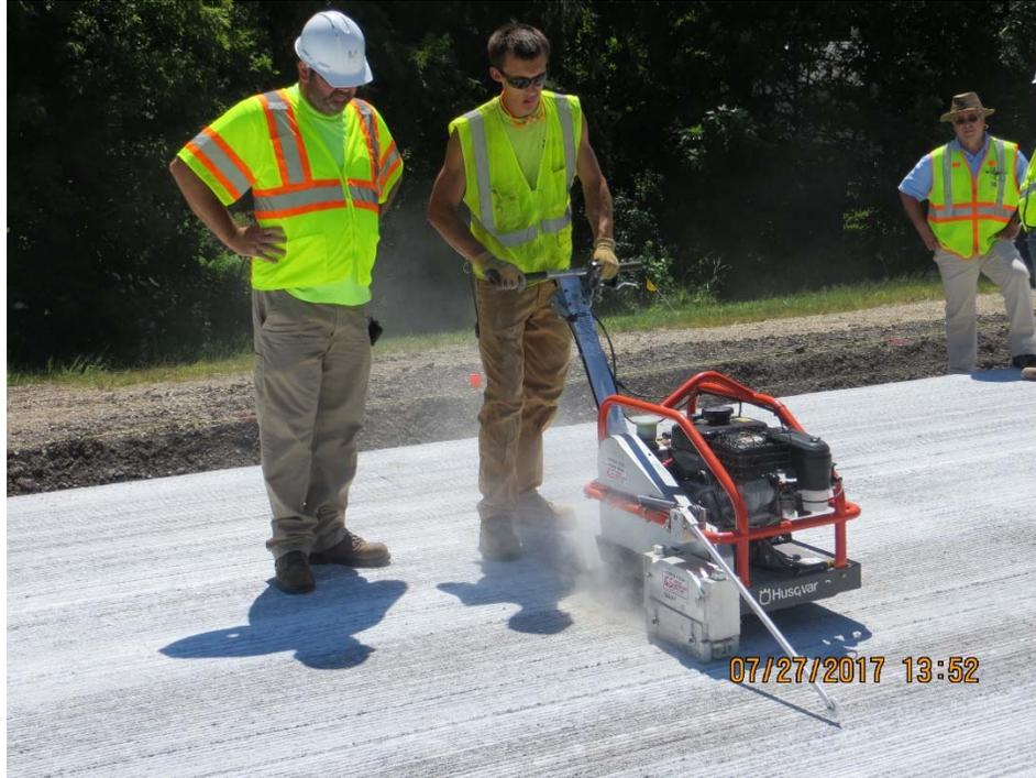
**Figure 2.10.12. Husqvarna SOFF-CUT Model 2000 Early Entry Sawing Operations**
