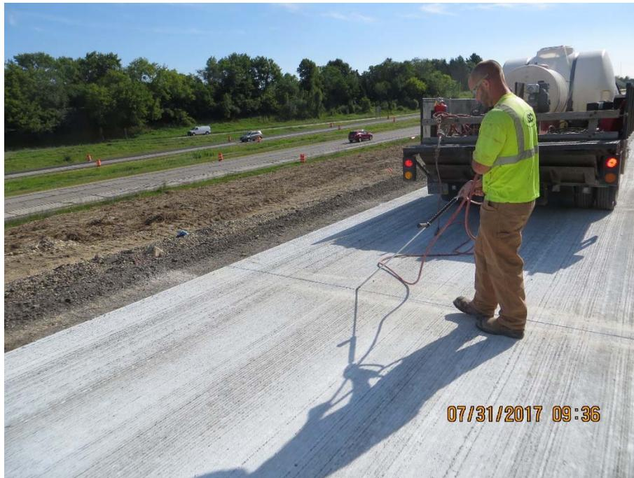
**Figure 2.10.16. Joint Sealing Operations**
