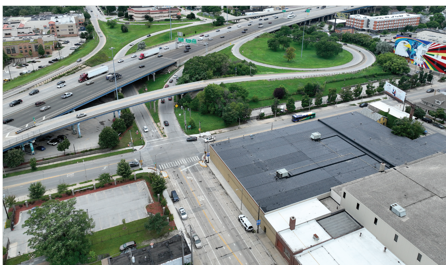
Existing I-43 interchange ramps at National Avenue. Rampas existentes del intercambiador de la I-43 en la avenida National Avenue.
