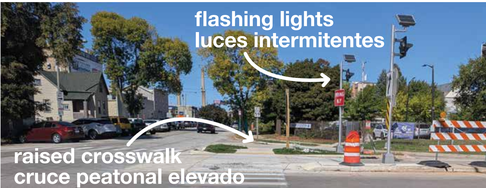
In 2025, WisDOT installed additional safety infrastructure at the ramps meeting 9th Street to improve pedestrian safety En 2025, WisDOT instaló infraestructura de seguridad adicional en las rampas que conectan con la calle 9th Street para mejorar la seguridad peatonal
