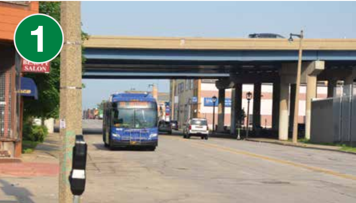
The study is coordinating with the National Avenue reconstruction and other nearby projects El estudio se está coordinando con la reconstrucción de la avenida National Avenue y otros proyectos cercanos
